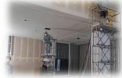
※アップスター 使用による高所作業状況
