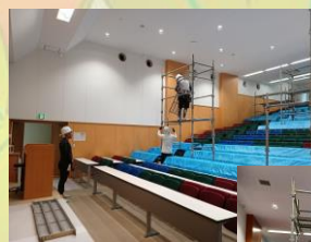
足場設置作業
